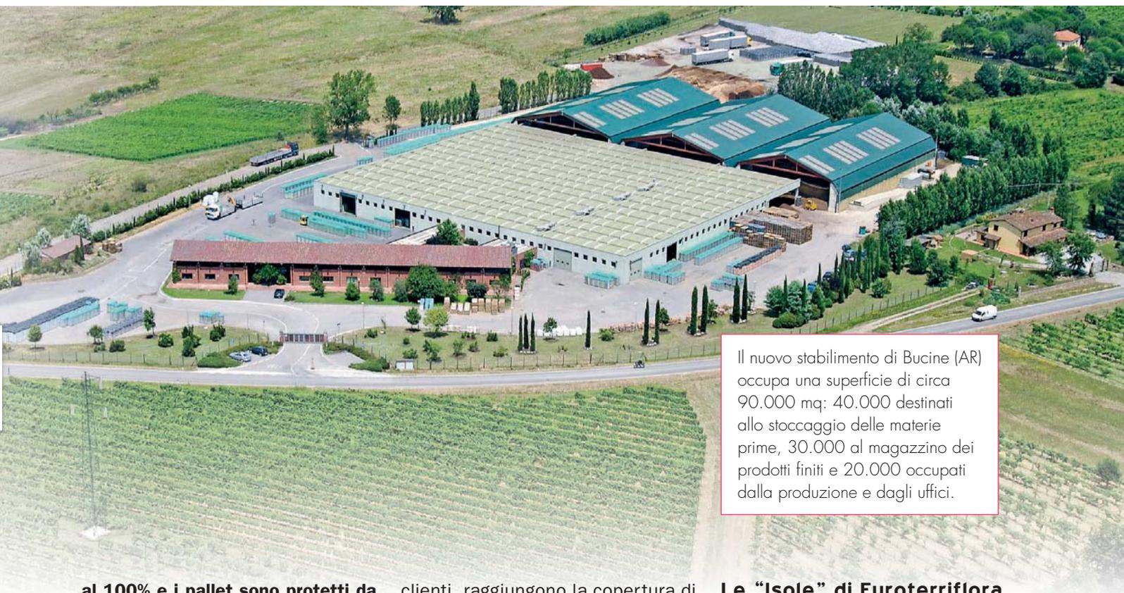
Il nuovo stabilimento di Bucine (AR) occupa una superficie di circa 90.000 mq: 40.000 destinati allo stoccaggio delle materie prime, 30.000 al magazzino dei prodotti finiti e 20.000 occupati dalla produzione e dagli uffici.
